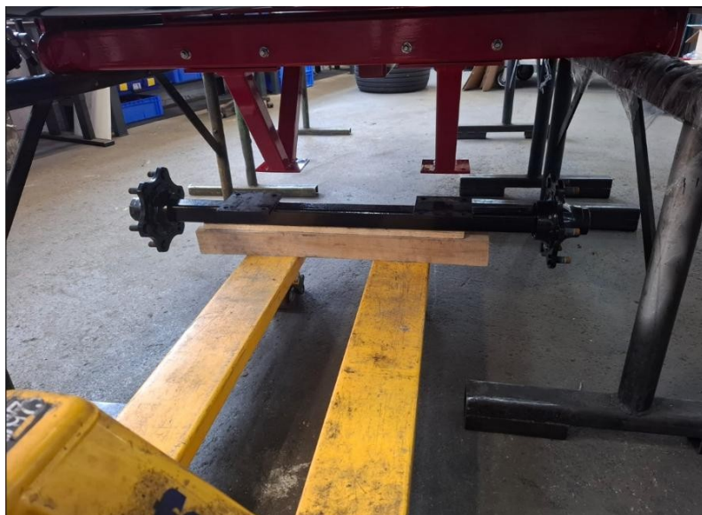
Kuva 15: Akselin asettaminen
